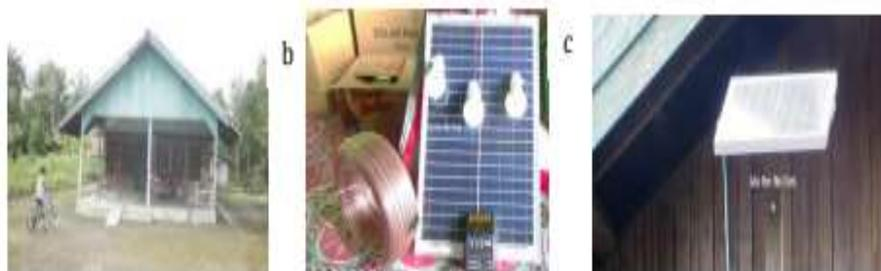
Gambar 3 (a) sebelum pemasangan; (b) paket tenaga surya skala mikro; (c) setelah pemasangan. *Sumber: Tim Keterlibatan Masyarakat (2024)*
